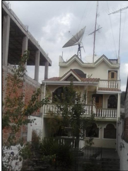
Figura 47 Antena en la Oficina
