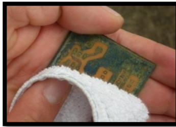
Figura 135. Lijado del circuito transmisor.
