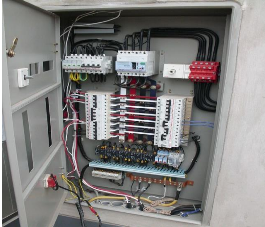
Figura 11: Tablero de energía
