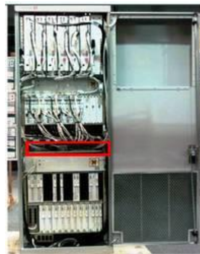
Figura 13: Equipos de radio base
