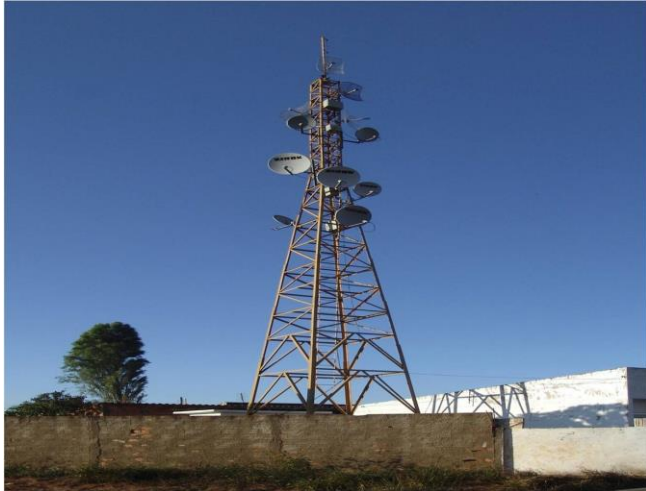
Figura14: Torre celular autosoportada
