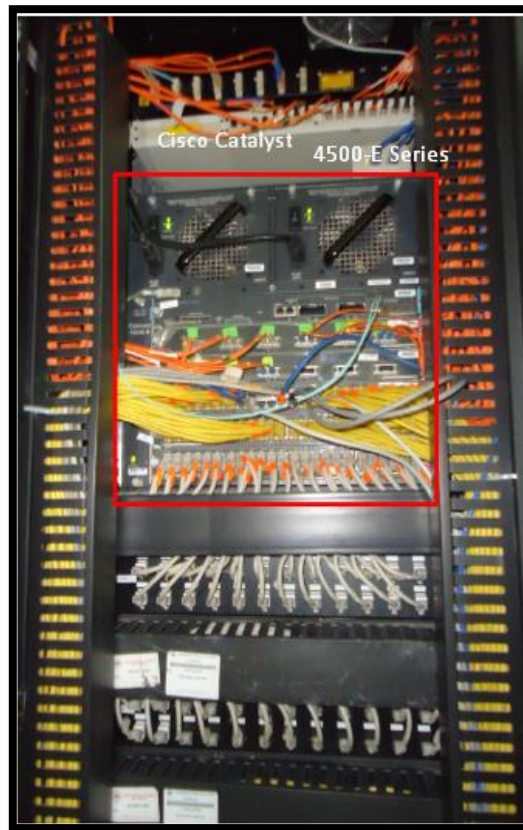
Figura 19. Cisco Catalyst 4500-E Series ubicado en el datacenter FICA Referencia: Datacenter FICA
