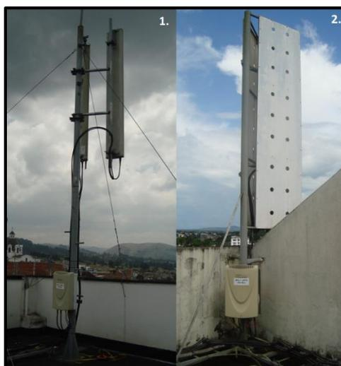
**Figura 9.** Mástiles con sin mimetización (1) y con mimetización (2)
