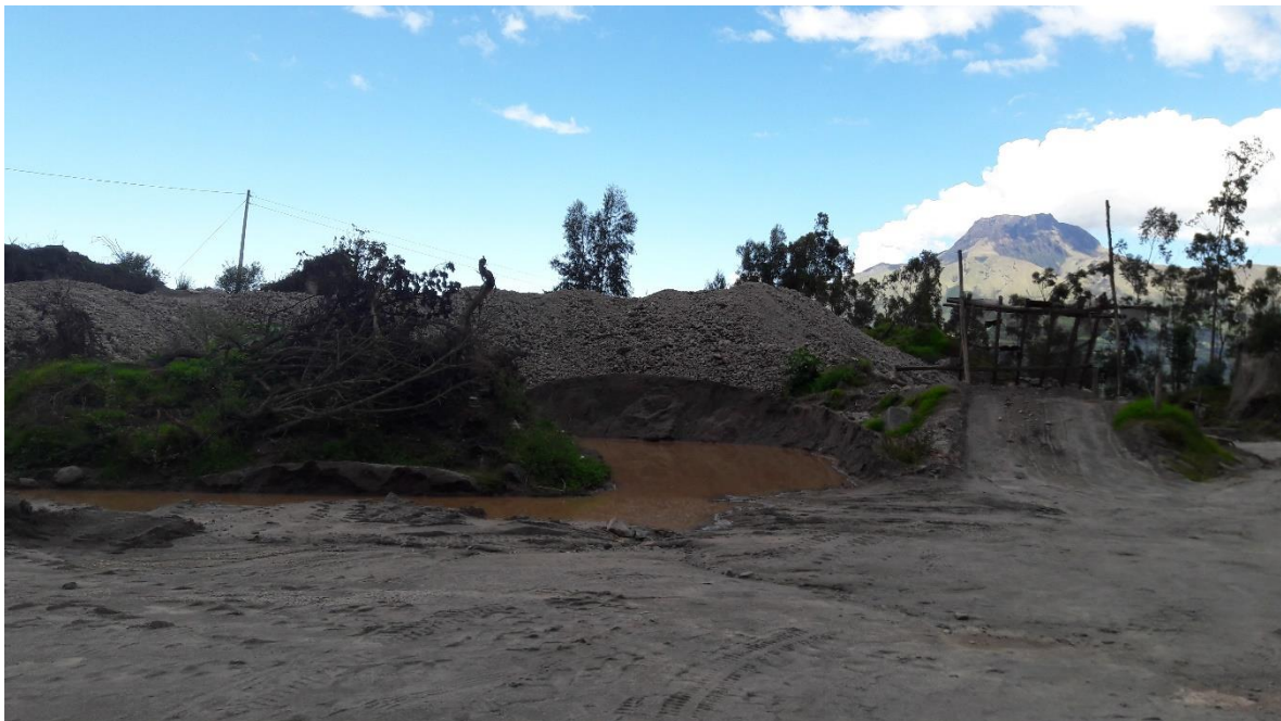
(Depósitos de material, no cuentan con las medidas necesarias)
