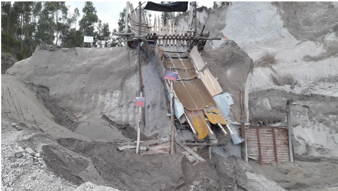
(Infraestructura para refinación del material, mal diseñada)
