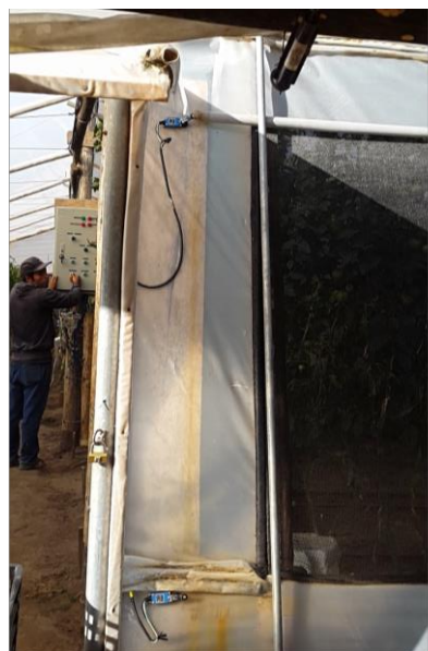
Figura 4.12 Interruptores de posición
