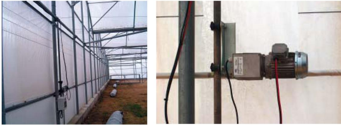
Figura 1.14 A la izquierda, banda lateral con CXP enrollable (De Gier) y, a la derecha motor-reductor con guía GXP (De Gier).
