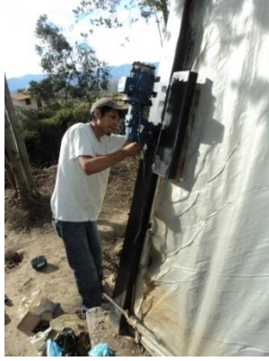
Figura 3.30 Instalación del motor-reductor
