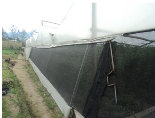
Figura 2.2 Sistema de apertura manual
