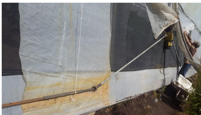
Figura 3.33 Instalación de la segunda junta universal
