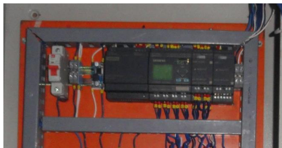
Figura 3.34 Instalación del PLC LOGO y módulos de expansión
