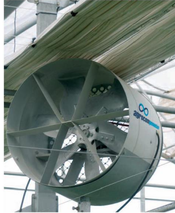
Figura 1.5 Ventilador para ventilación forzada.
