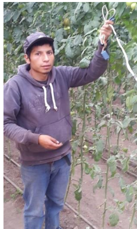
Figura 3.37 Instalación de sensor de humedad relativa
