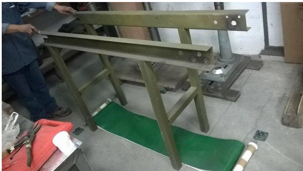
FIGURA 34 Ensamble de la estructura
