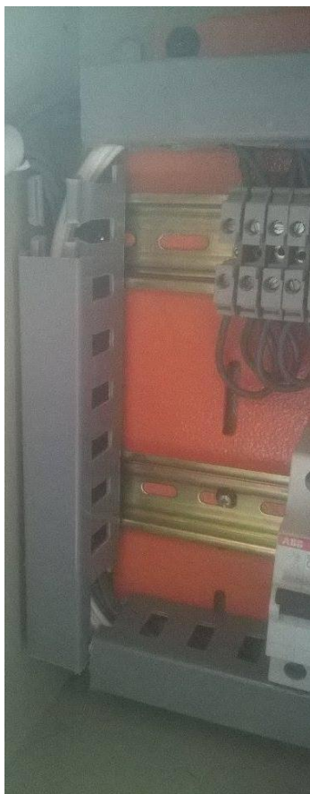
FIGURA 70 Montaje de canaletas
