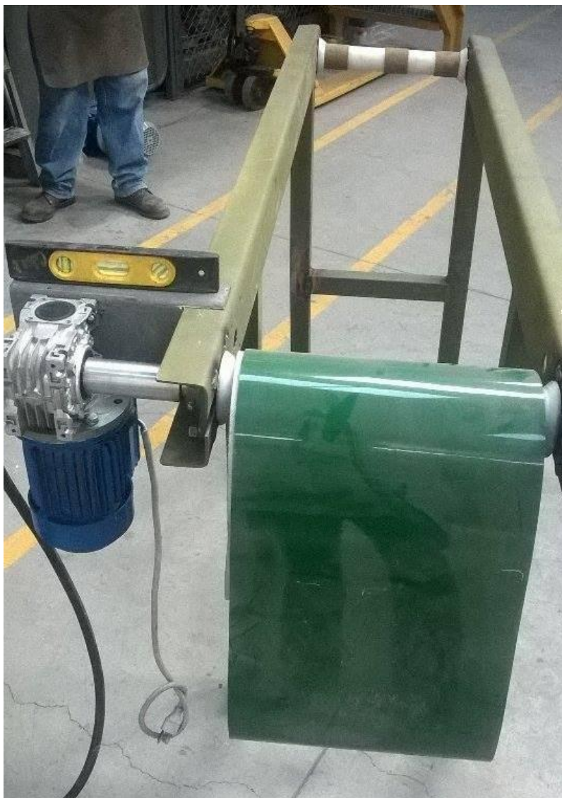
FIGURA 43 Montaje del motorreductor
