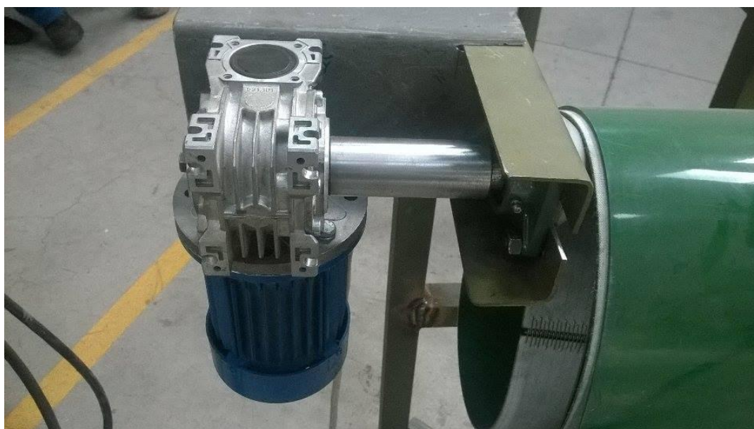
FIGURA 42 Montaje del motorreductor
