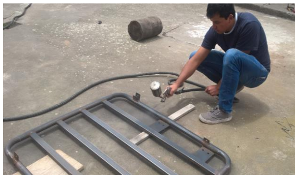
Figura 3.63. Colocación de la pintura sobre la parrilla
