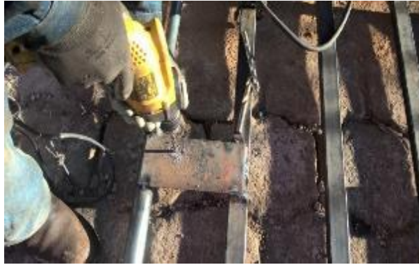
Figura 3.60. Perforación de los asientos para dar paso a los pernos
