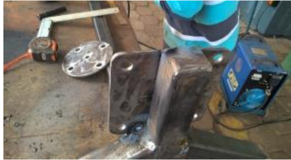
Figura 3.79. Instalación de los asientos en la estructura del Savonius
