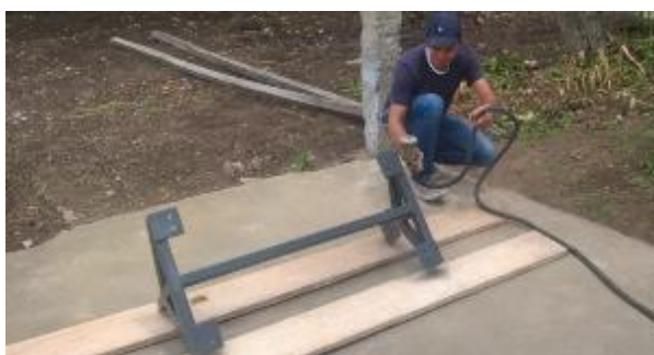
Figura 3.84. Colocación de la pintura sobre la estructura del Savonius
