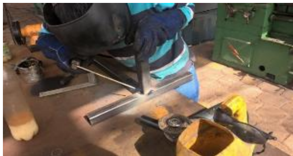
Figura 3.72. Soldadura de los tubos de la estructura del aerogenerador
