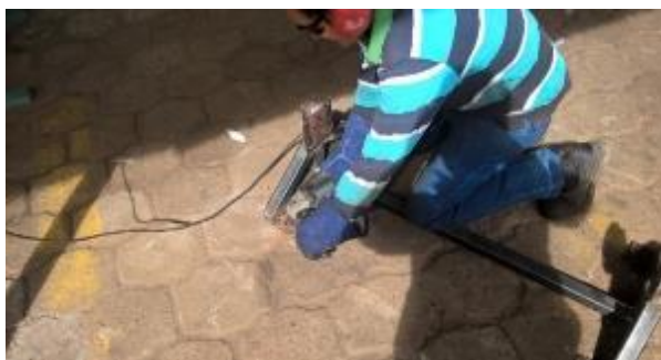
Figura 3.83. Eliminación de escoria en la estructura del Savonius
