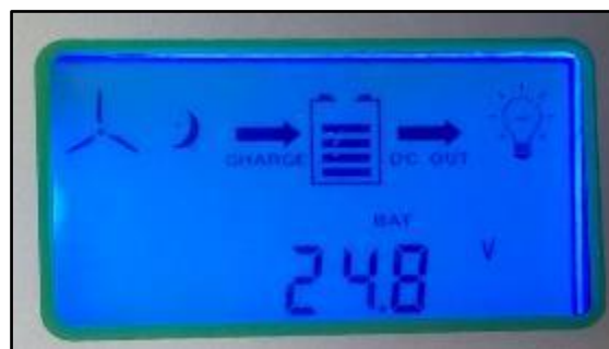
Figura 4.19. Voltaje de la batería en estado de carga
