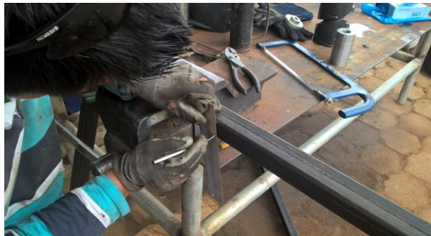
Figura 3.69. Medición de los tubos de perfil cuadrado
