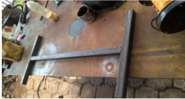
Figura 3.71. Montaje de los tubos que forman la estructura del Savonius
