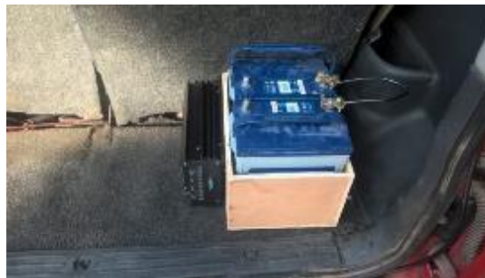
Figura 3.89. Conexión de las baterías en serie
