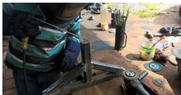
Figura 3.73. Instalación de las tapas en la estructura del Savonius
