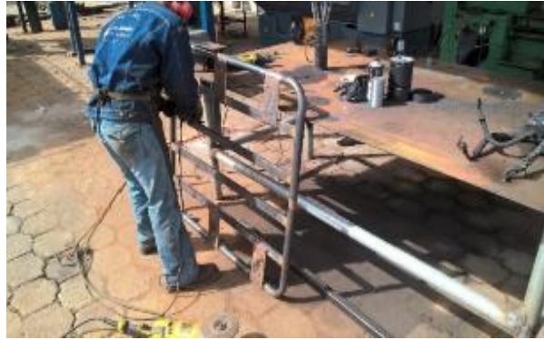
Figura 3.62. Desprendimiento de escoria de soldadura de la parrilla
