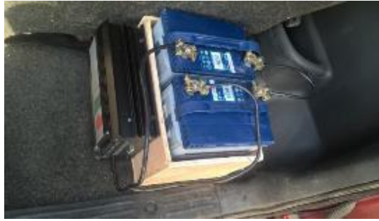
Figura 3.90. Conexión de las baterías al controlador de carga
