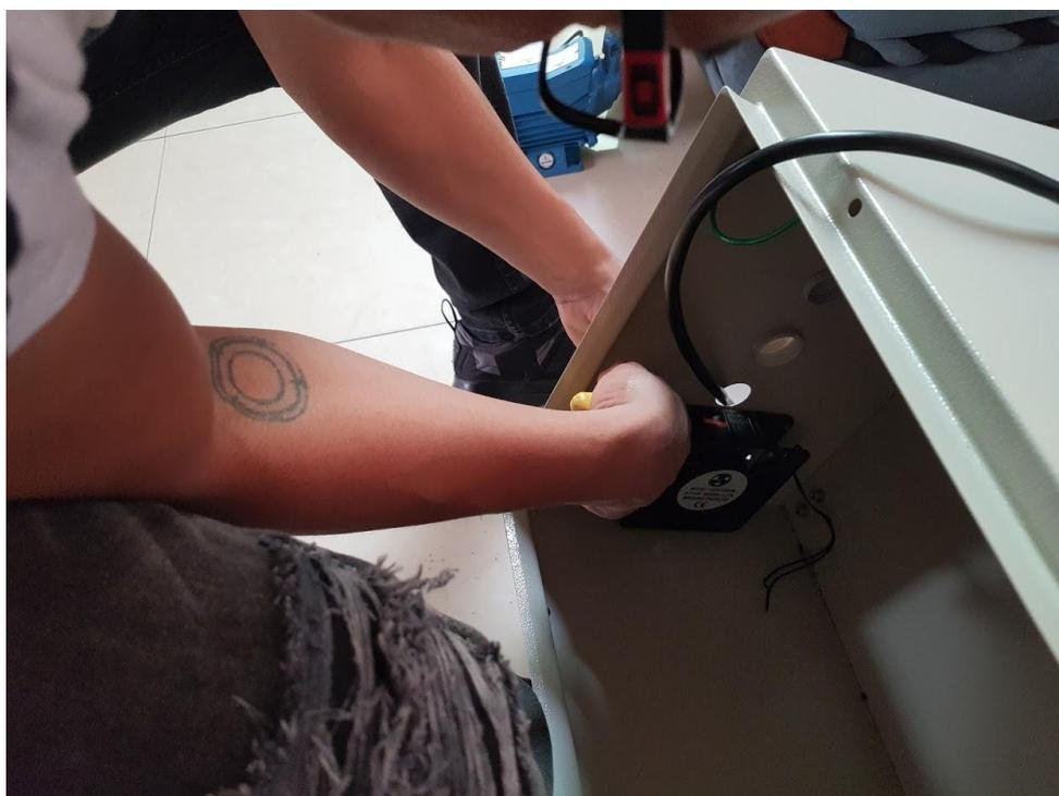
Figura 71 Perforación de orificios para ventilación
