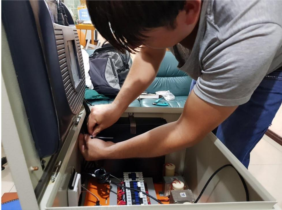
Figura 76 Sujeción de cables
