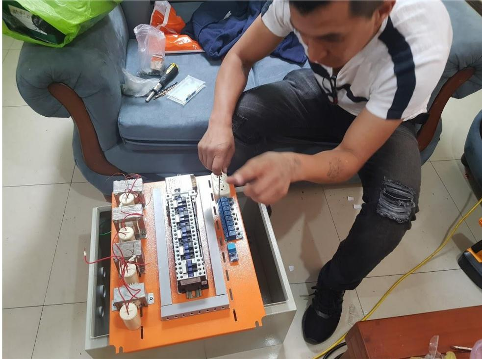
Figura 68 Montaje de barra de relé
