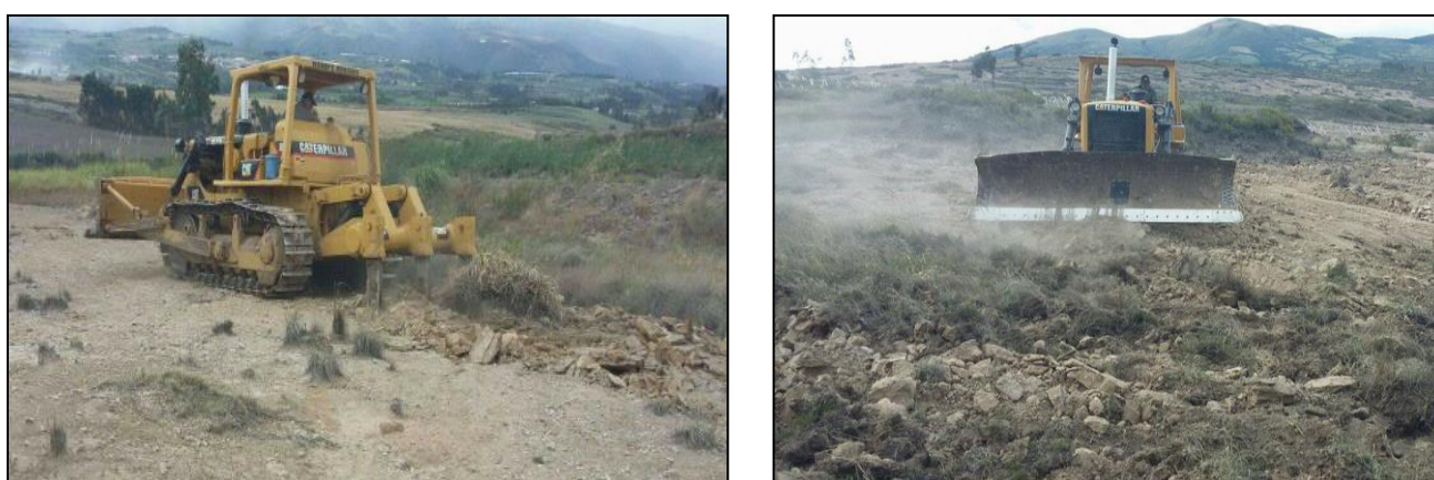
Figura 3.4 Roturación del suelo.
