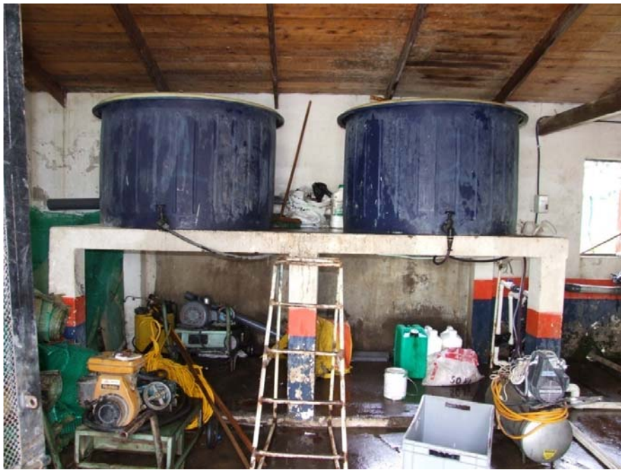
Anexo N° 74. Fotografía 31. Tanques de fertilización y riego
