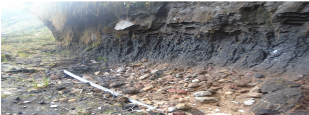
Figura 2.4 Tubería de conducción tipo PVC
