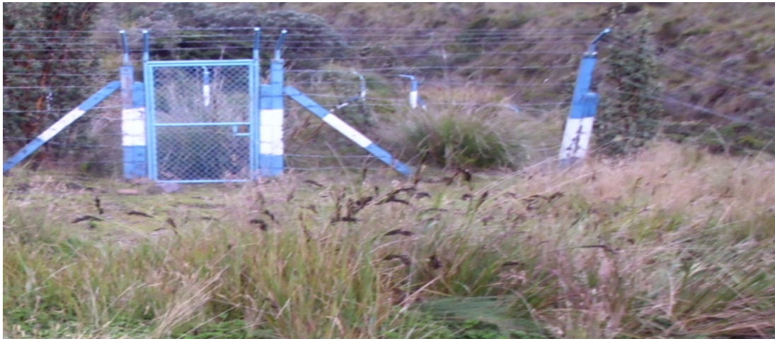
Figura 4.4 Verificación de cerramiento en la captación
