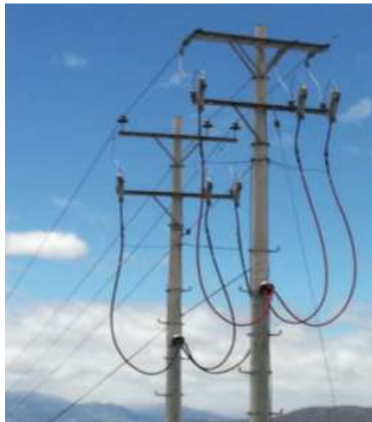
Fig. 23 Punto de conexión entre el “Parque Solar Salinas” y la red de media tensión pública de Emelnorte S.A. (Autor)
