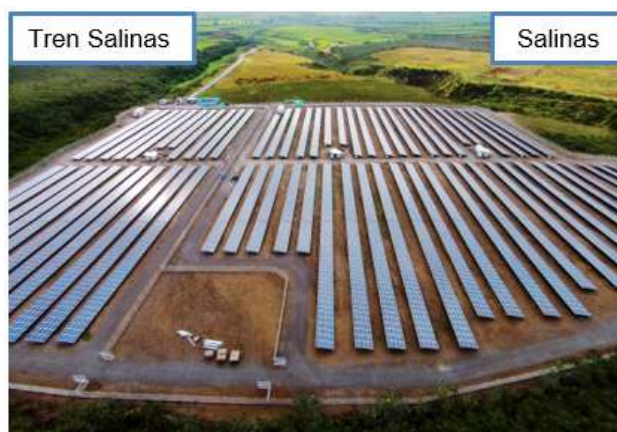
Fig. 16 Planta fotovoltaica “Parque Solar Salinas” (Holding, 2014)
