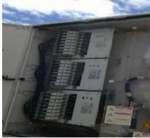
Fig. 19 Caja de conexión string (Autor)
