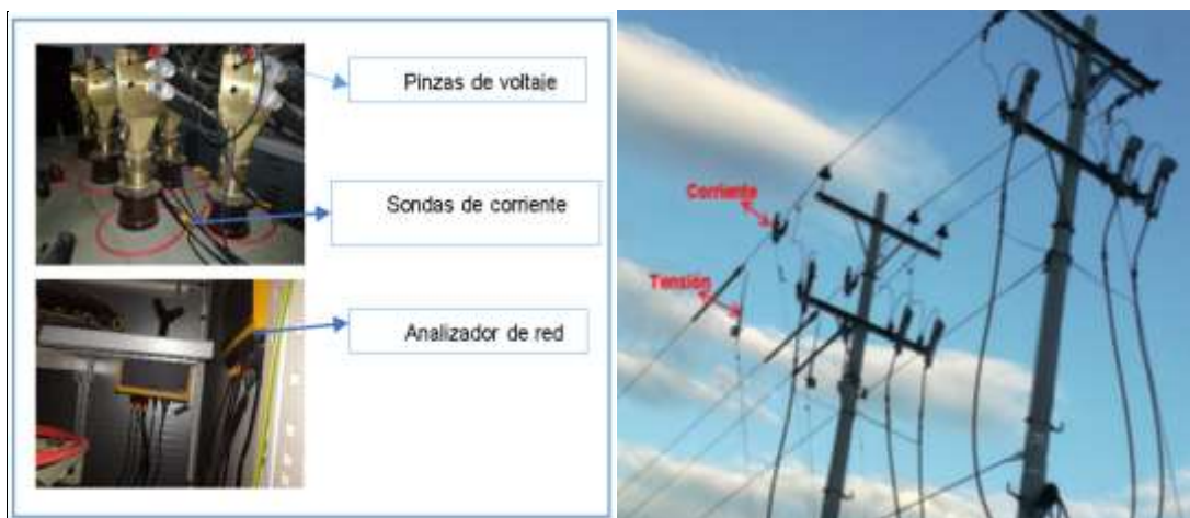
Fig. 25 Conexión de los analizadores de red (Autor)
