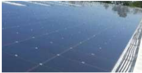
Fig. 5 Panel solar fotovoltaico de capa fina (Renovables, 2014)
