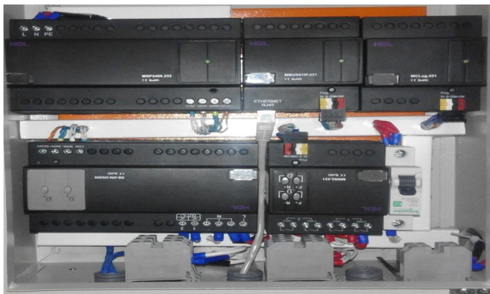
Figura 91: Conexión de los equipos HDL Buspro Fuente: Autor
