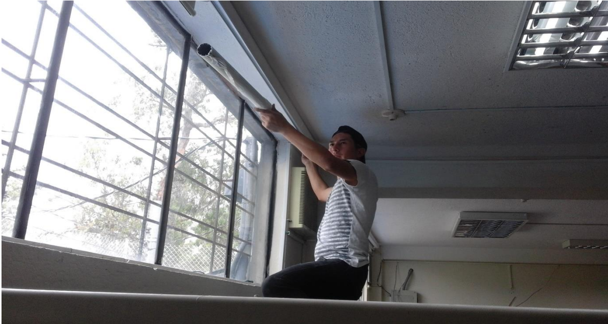
Figura 165: Instalación de persiana Fuente: Autor
