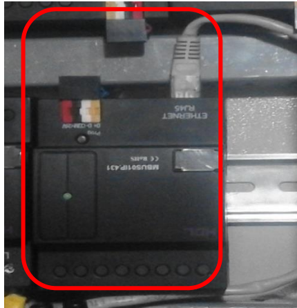
Figura 164: Conexión física del módulo IP
