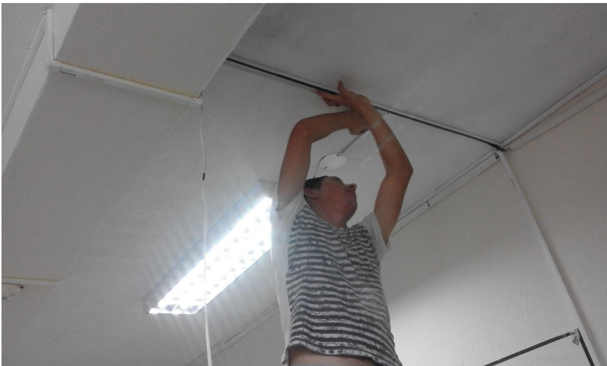
Figura 166: Instalación de cableado para bombillas LED Fuente: Autor
