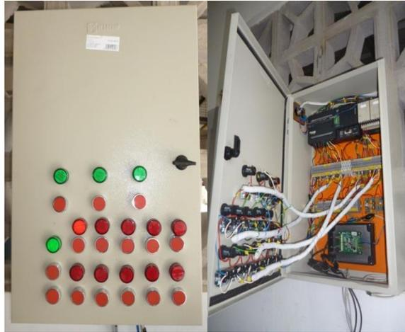
*Figura 2.38.* Gabinete de Control Electrónico.
