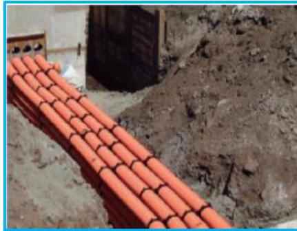
Fig. 2.4 Instalación de los ductos con sus respectivos separadores.
