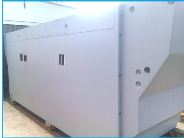
Fig. 1.17 Cámara de seccionamiento tipo Iceberg, con ventilación horizontal.
