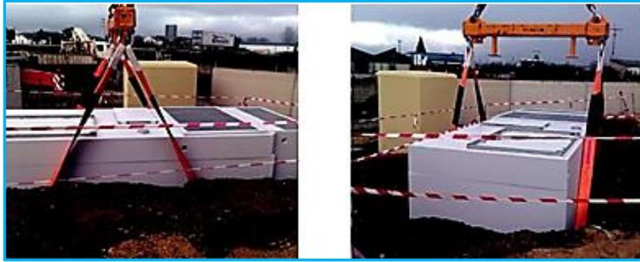
Fig. 2. 33 Instalación de una cámara de seccionamiento.
