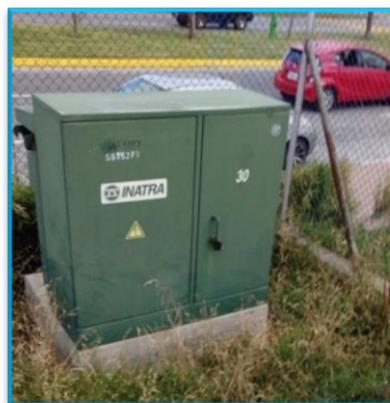
Fig. 1.15 Cámara de seccionamiento a nivel del suelo o tipo Padmounted.
