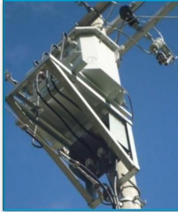
Fig. 1.14 Centro de transformación tipo interperie.
