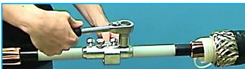
Fig. 2.17 Instalación del conector torquimétrico.
