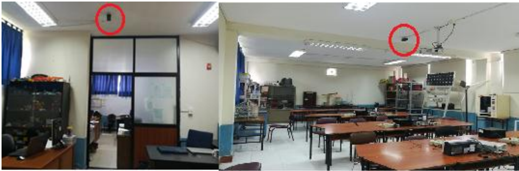
Fig. 2.39 Instalación de detectores de humo Fuente Autor
