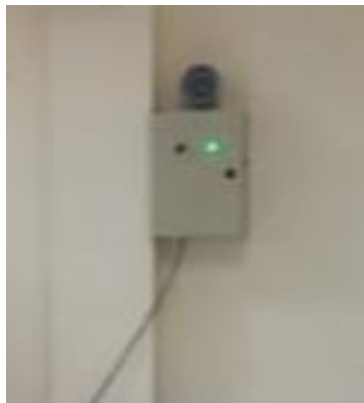
Fig. 2.40 Montaje del módulo de control Fuente Autor
