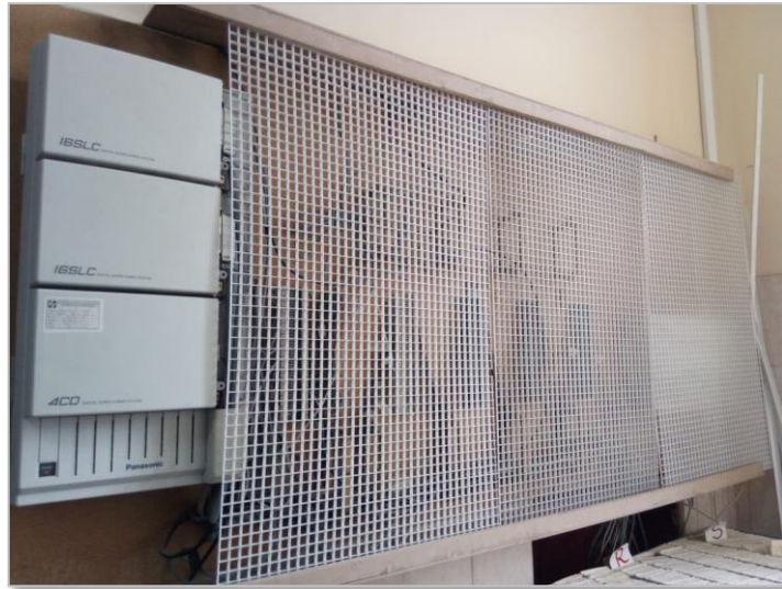
Figura 14. Central telefónica analógica ubicada en oficina de Estadística
