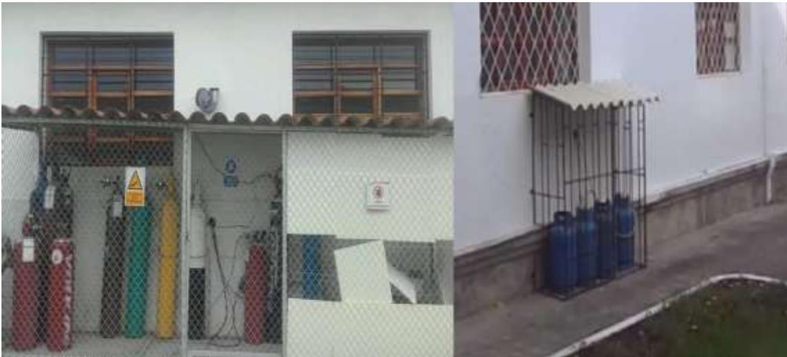
**Figura 12.** Tanques Industriales de gases comprimidos y GPL
