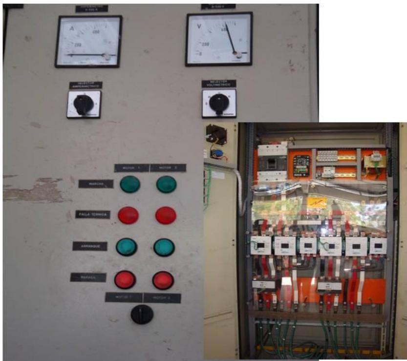
Fig. 2.7.- Tablero principal de control, bomba-zona1
