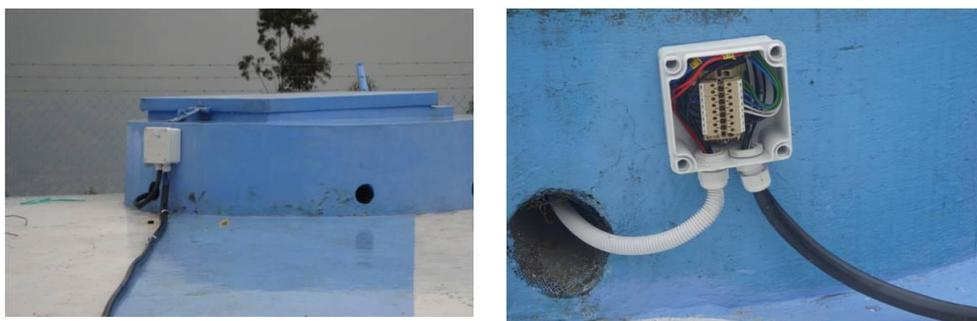
Fig. 6.7. Caja de revisión de sensores
