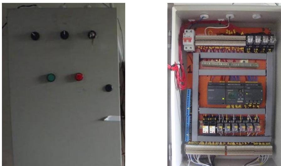
Fig. 6.3. Tablero de automatización zona 1
