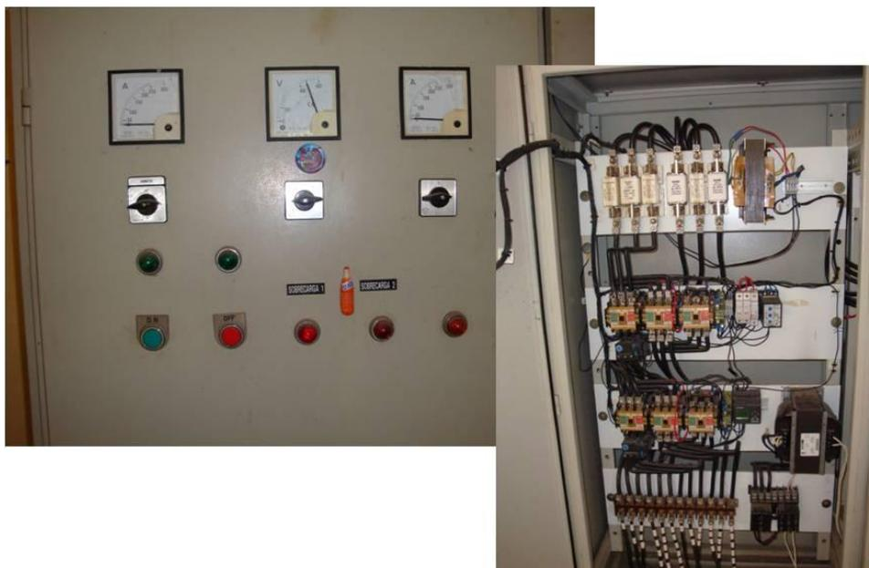
Fig. 2.8.- Tablero principal de control, bomba-zona 2
