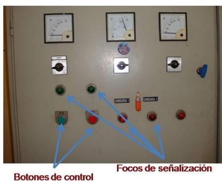
Fig. 9 Botones y luces del tablero principal de la zona 2
