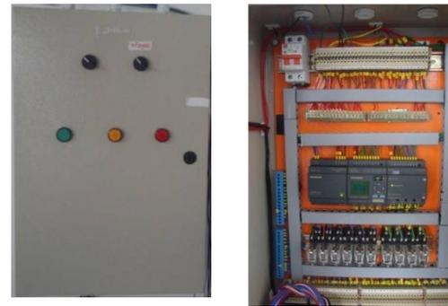
Fig. 15. Tablero de automatización zona 2
