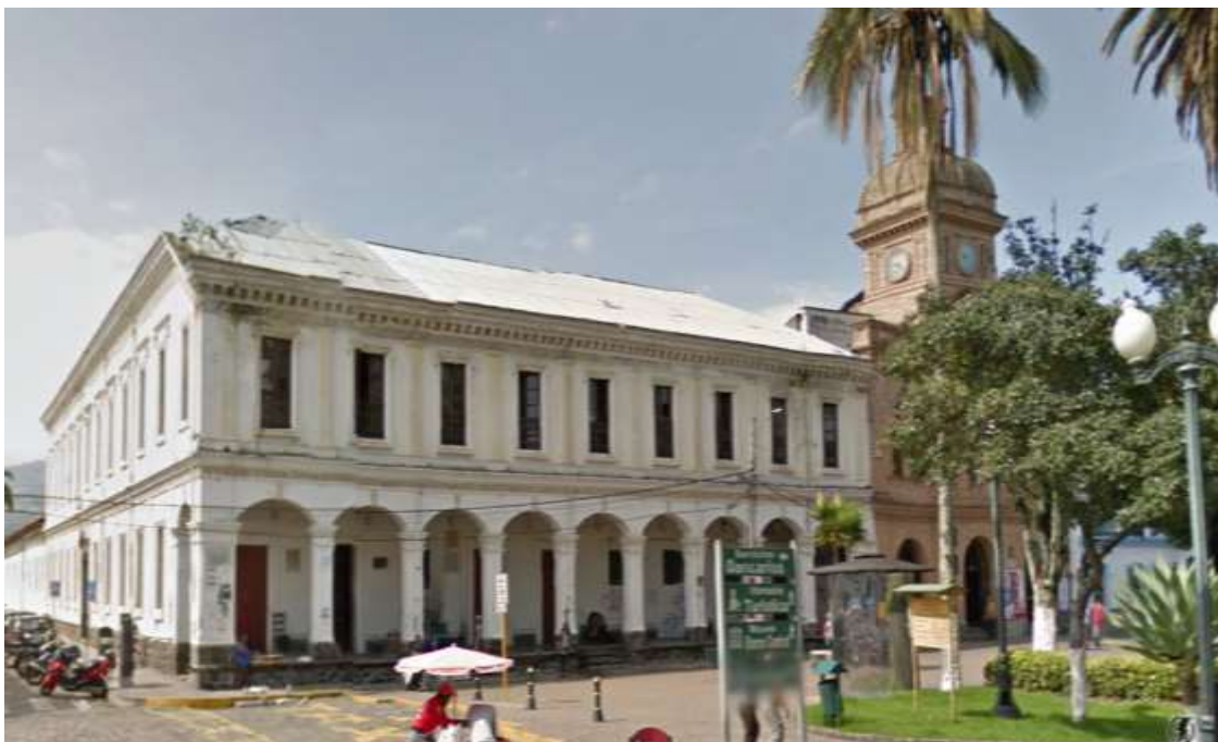
Figura Nº 3 Fachada antiguo edificio “Teodoro Gómez de la Torre”.
