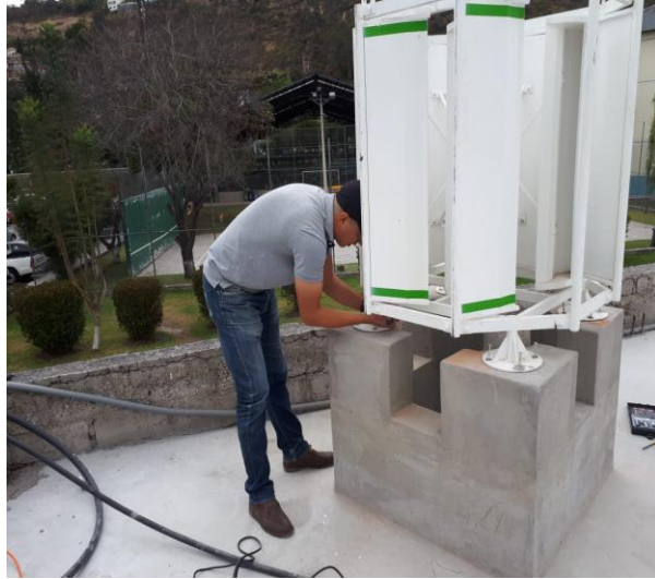
FIGURA 20. INSTALACIÓN DEL MICRO GENERADOR EÓLICO. Fuente: Autor
