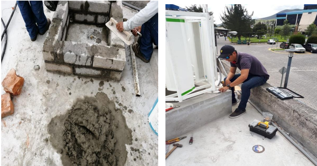
FIGURA 19. CONSTRUCCIÓN DE LA ESTRUCTURA SOPORTE Y MONTAJE DEL MICRO GENERADOR EÓLICO. Fuente: Autor
