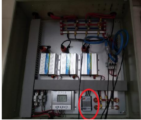
FIGURA 23. INSTALACIÓN DEL REGULADOR DE CARGA EÓLICO. Fuente: Autor
