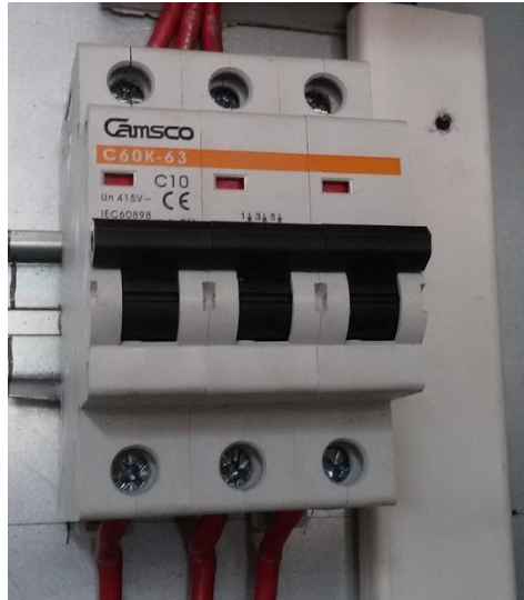
FIGURA 28. INSTALACIÓN DEL INTERRUPTOR TERMO MAGNÉTICO DE 10 (A) 3 POLOS. Fuente: Autor
