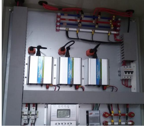
FIGURA 29. MONTAJE DEL TABLERO DE GENERACIÓN Y CONTROL. Fuente: Autor
