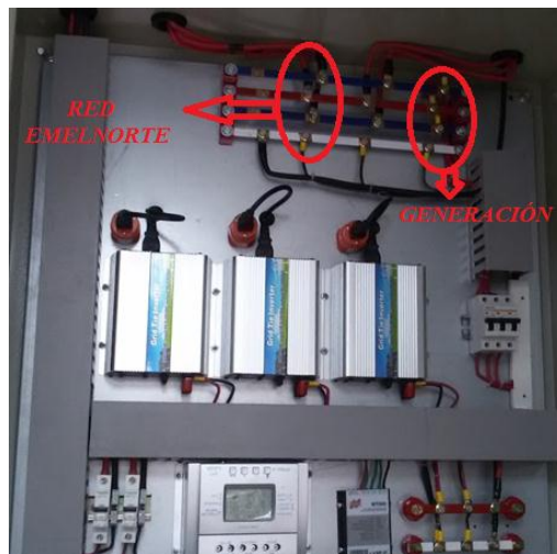
FIGURA 30. CONEXIÓN DEL SISTEMA DE GENERACIÓN HÍBRIDA CON LA RED ELÉCTRICA DE DISTRIBUCIÓN. Fuente: Autor
