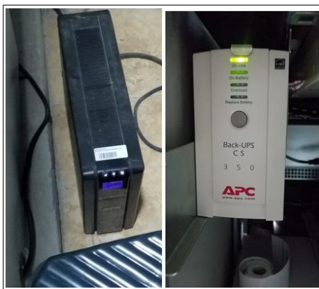
Fig. 40. Seguridad de la Fuente interna del ATM Fuente: Propia
