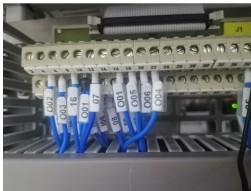
Figura 29. Cambio posición del cable pulsador Robot AUTO/MAN
