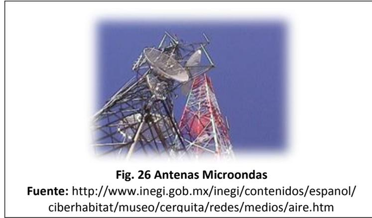
Los microondas utilizan el espacio aéreo como medio físico de transmisión. La información se transmite en forma digital a través de ondas de radio. Pueden direccionarse múltiples canales a múltiples estaciones dentro de un enlace dado, o pueden establecer enlaces punto a punto. Las estaciones consisten en una antena tipo plato y de circuitos que interconectan la antena con la terminal del usuario.
