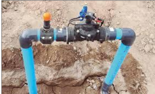
Figura 12: Cabezal de campo con válvulas hídricas. Fuente: (Liotta, 2015).
