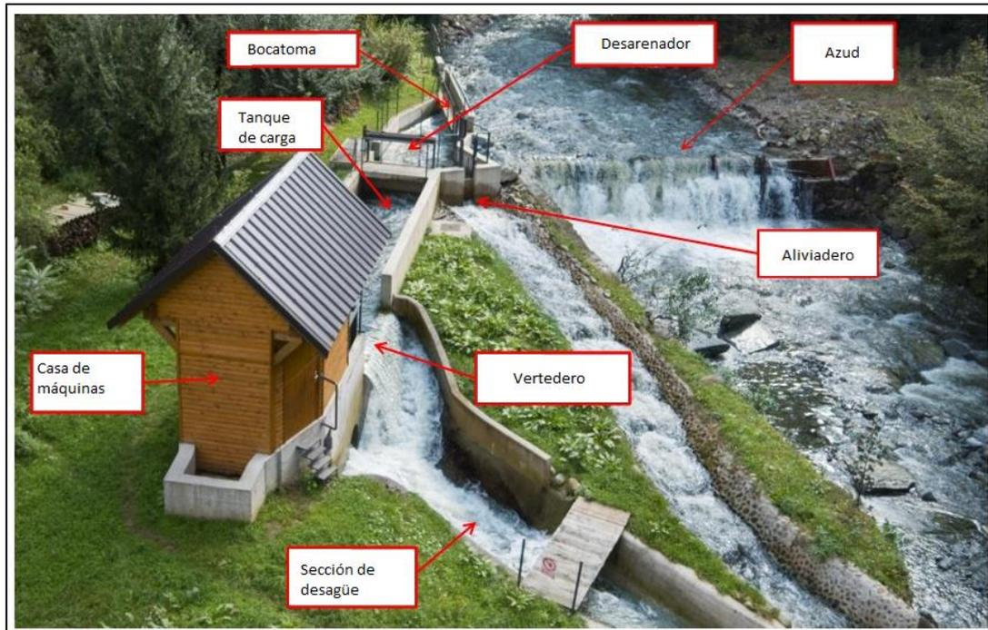
Fig. 10. Componentes de una micro central.
