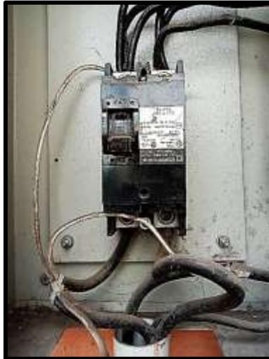
**Figura 2.5** Interruptor automático general de los Bloques
