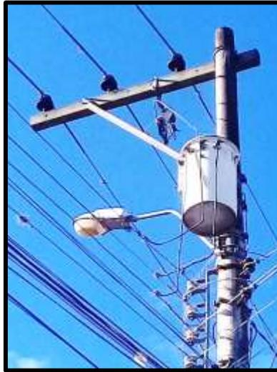
**Figura 1.3** Transformador de distribución monofásico
