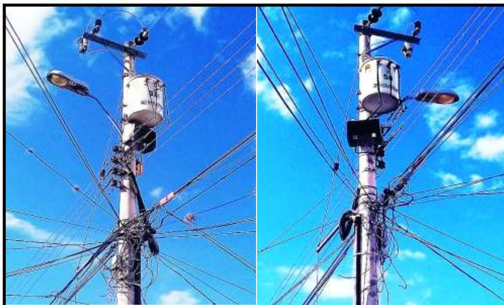
**Figura 2.9** Centros de transformación aérea existentes de 37,5 – 50 kVA
