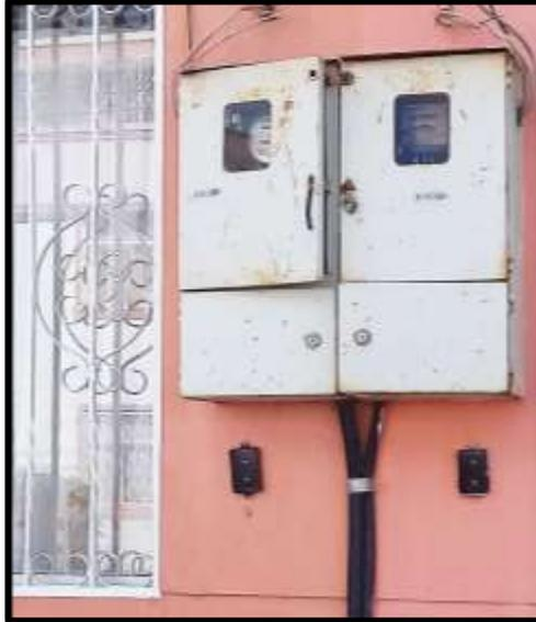
**Figura 2.10** Caja de protección de medidores
