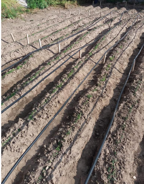
Figura 54. Preparación de la parcela e instalación de mangueras Fuente. Autoría
