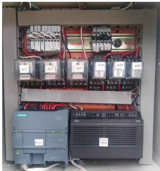
*Figura 2-22 Componentes del automatismo ubicados en el interior del tablero de control*
