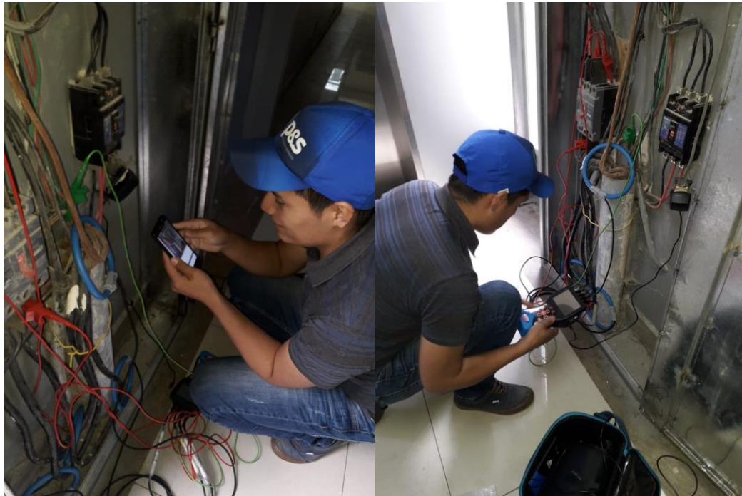
Anexo 3. Instalación del analizador de red en la tercera medición
