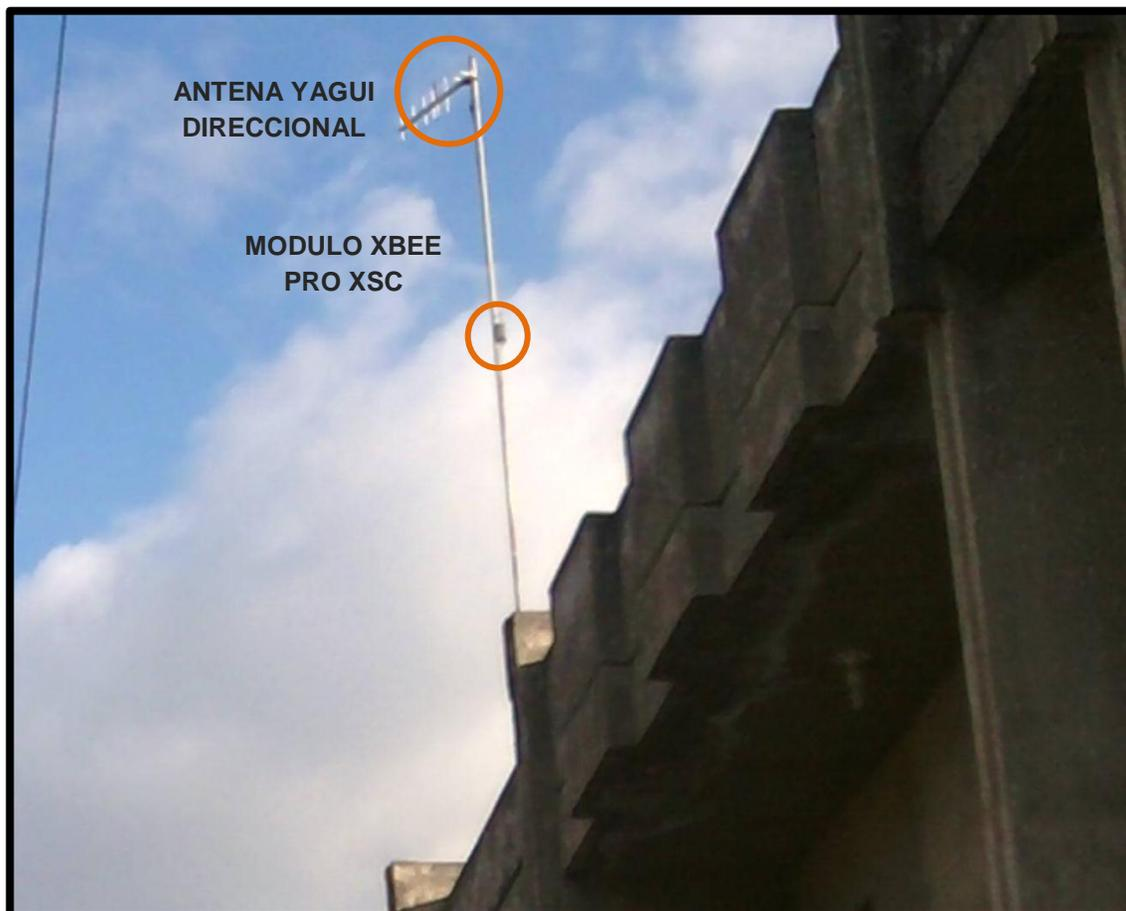
**Figura 91. Infraestructura para la colocación de la antena en la Oficina Central de la Junta Administradora de Agua Potable Sumak-Yaku.**
