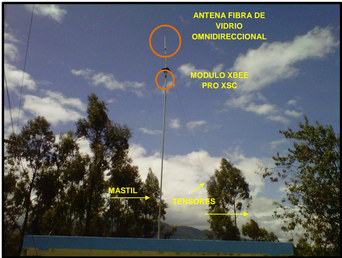
**Figura 89. Infraestructura para la colocación de la antena en la Estación de Bombeo II.**
