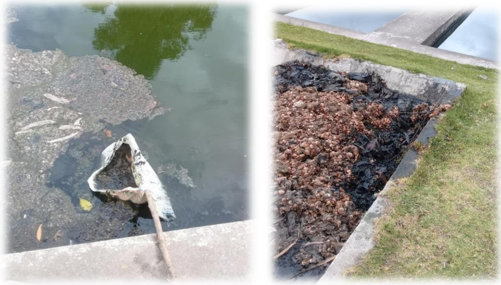
Figura 36. Limpieza se natas de los cárcamos de los humedales artificiales.
