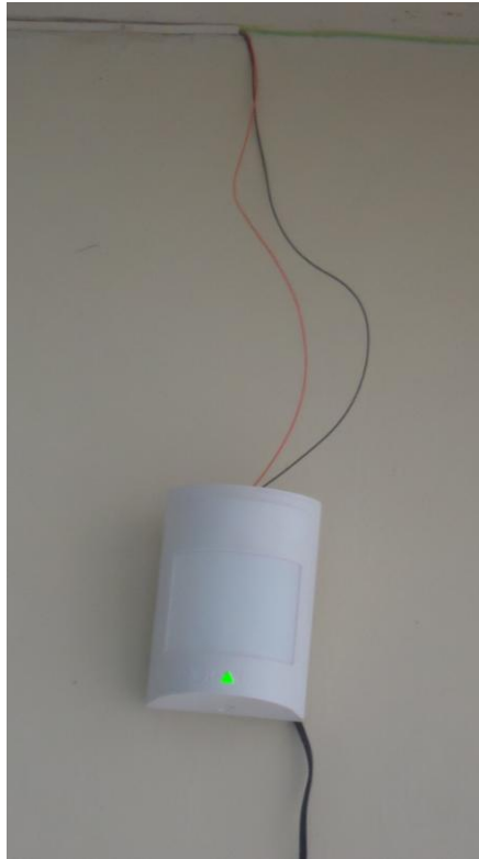
Imagen 15.- Instalación de un sensor de movimiento (Fuente: propia)
