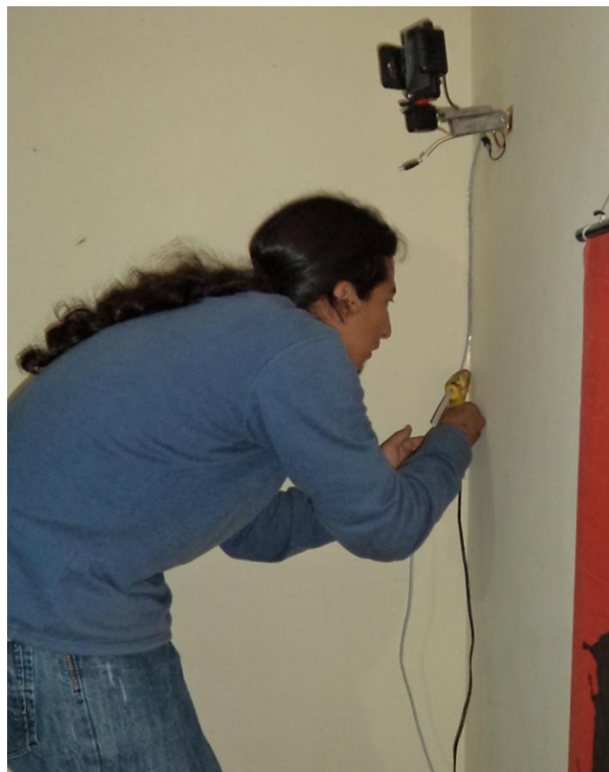
Imagen 14.- Colocando los cables que conectan al dispositivo servidor con el prototipo (Fuente: propia)
