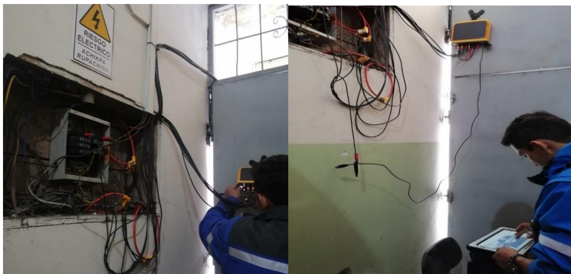
Fig. 2.19: Instalación del analizador de redes para la medición del factor de potencia.
