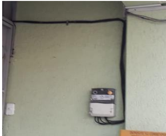
Fig. 2.5: Circuito de alimentación principal
