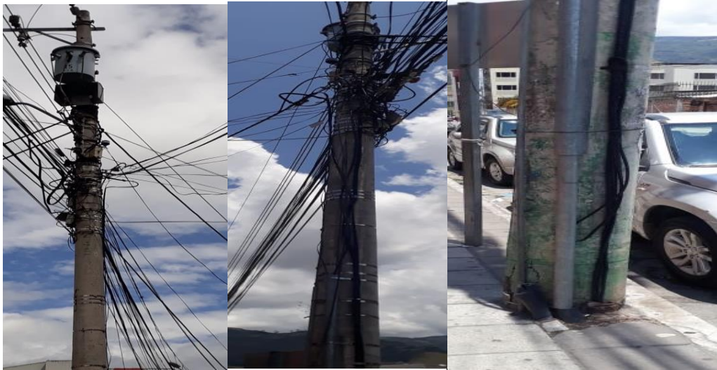
Fig. 2.3: Acometida subterránea de EMELNORTE S.A.
