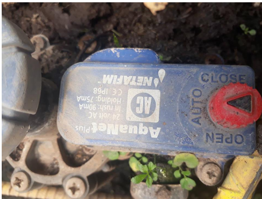
Ilustración 16: Solenoide acoplado a válvula de paso Elaborado por: Luis Chacón Fuente: Propia
