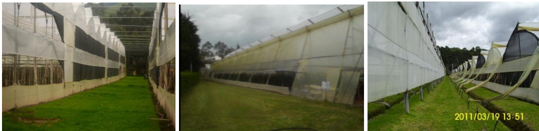
Fotografías Vista Externa de Bloques
