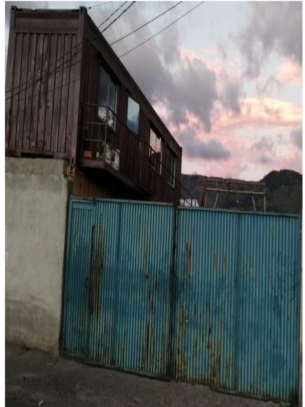
Figura 2. Taller Montajes Industriales Metalmecánicos. Fuente: elaboración propia
