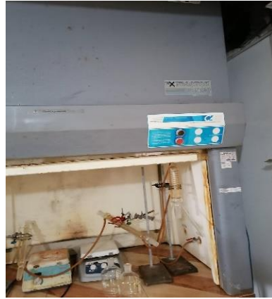
Anexo 14. Cabina de extracción de gases
