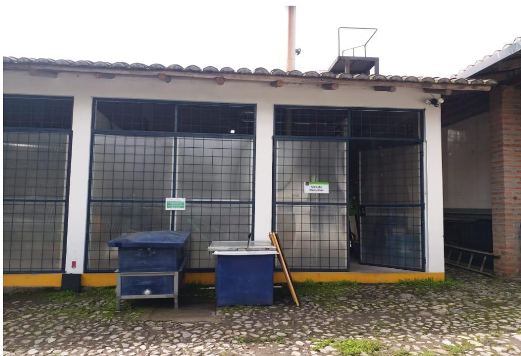
Anexo 25. Visita al área de máquinas.
