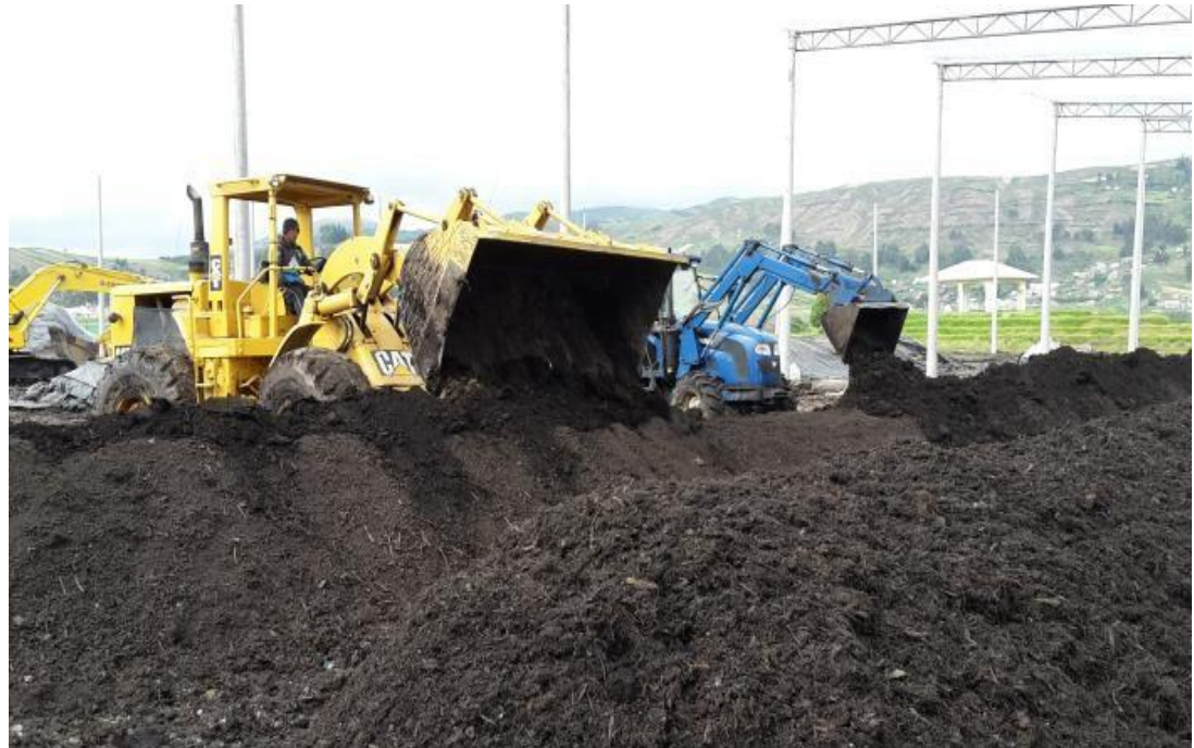
Figura 5 Depósito y tendido de material en interiores del invernadero
