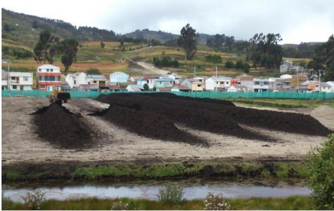
Figura 4 Depósito y tendido de material en exteriores del invernadero
