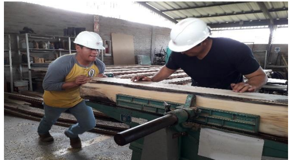
Preparación y escuadrado de bloques de madera.
