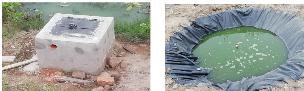
Figura 5. Caja de máquinas y fosas de captación de agua residual
