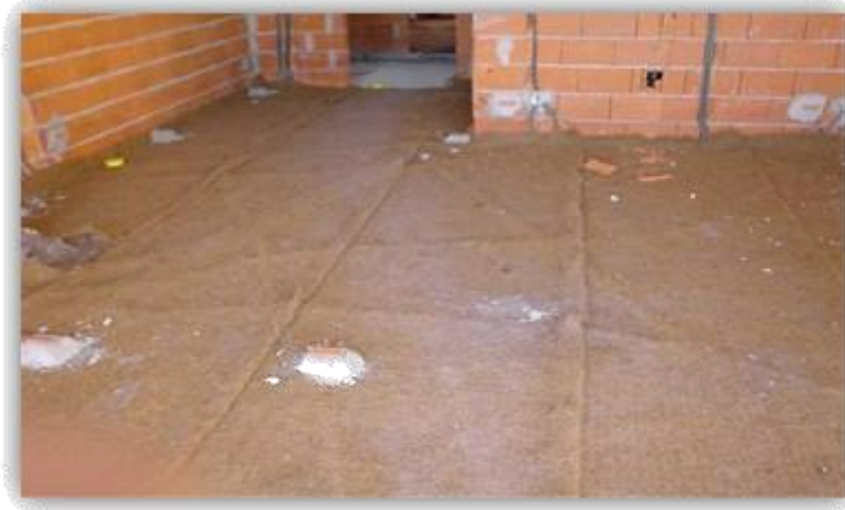
Figura 3. Panel de fibra de coco para reforzamiento térmico de pisos Fuente: (Isolamentos S.A., 2018)
