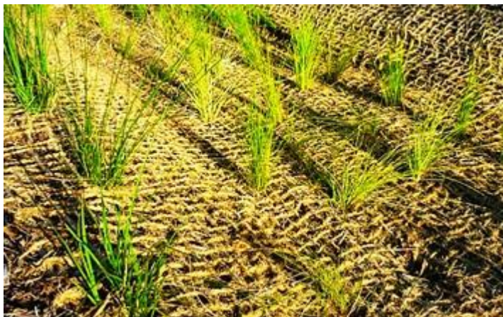
Figura 4. Geotextil de fibra de coco para controlar la erosión del suelo Fuente: (Sustratos, 2017)
