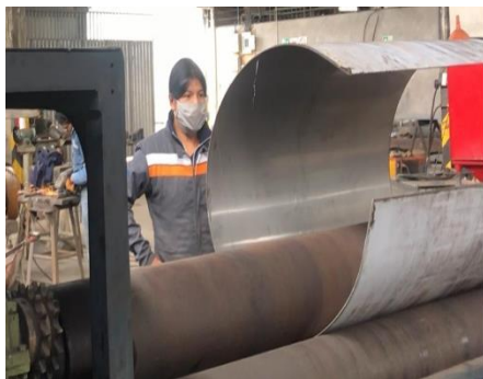
Fig. 4.5 Construcción del cilindro.
