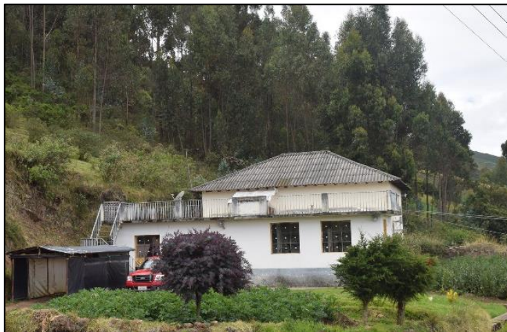
Fig. 2.1: Casa de máquinas minicentral “Espejo” Fuente: Erik Gustavo Delgado Pabón, 2020.
