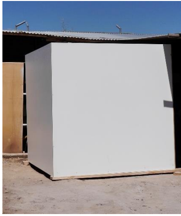
Figura 44. Instalación armada en blanco, melamínico Fuente: Autoría propia.
