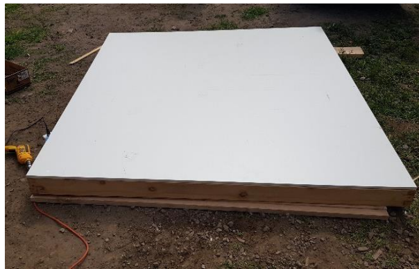
Figura 41. Estructura de base forrada con Melamínico.
