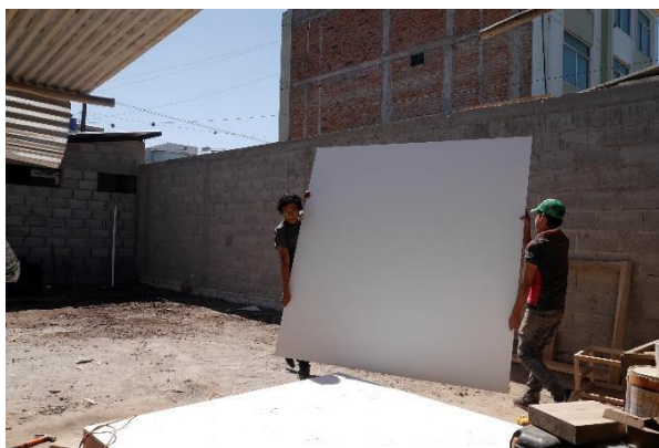
Figura 42. Primera pared ensamblada, melamínico
