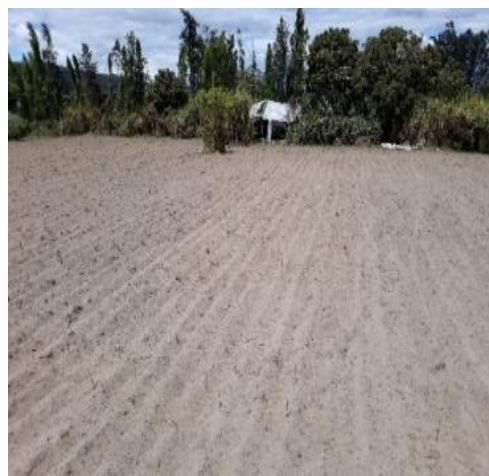
Figura 19. Delimitación y preparación del terreno
